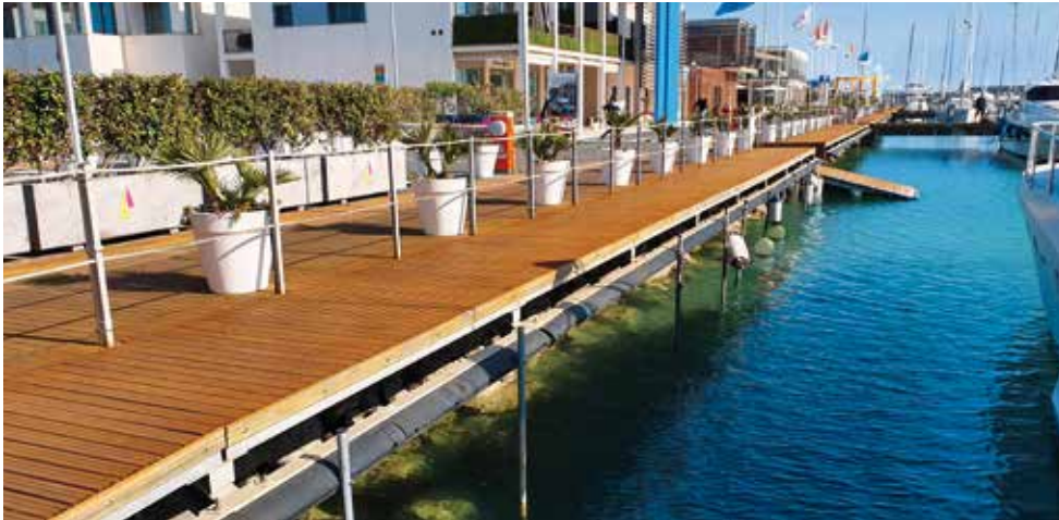
Prefabricated quay, Marina Cala dei Medici, Rosignano - Italy
